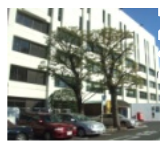
耐震補強した第3庁舎
