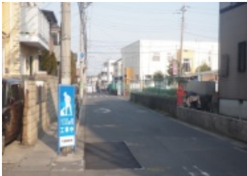
下水道工事中の宮久保3丁目22番地(写真：3月4日)
