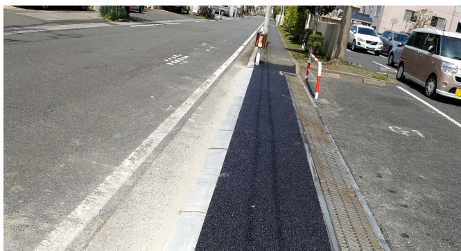
改修工事終了直後撮影
