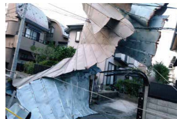
→台風15号のとき、国分の住宅で突風により屋根がはがれて、畳もふすまもびしょ濡れ
