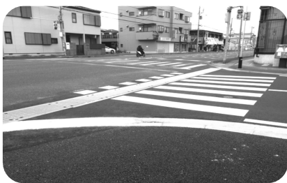
道の段差が解消された
