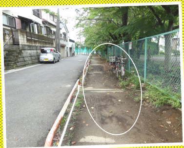
雨ですぐ冠水する歩道（稲越町）
