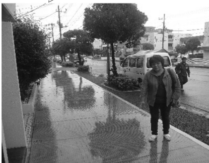
南行徳ふた掛け歩道の改修後
