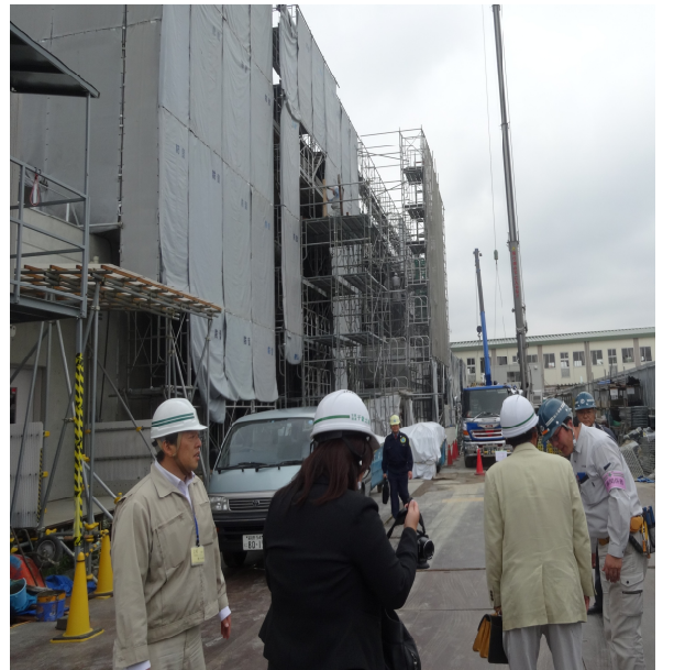
国分小学校の建替入現場を視察。現場監督から労務単価の引き上げや法定福利費の現状を伺う(6月13日)
