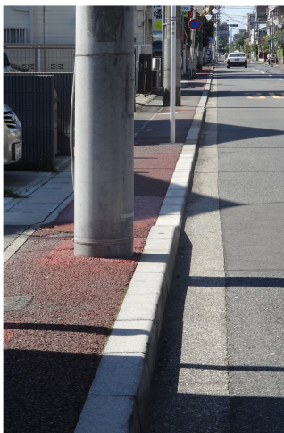
歩道の中央に設置されている電柱（南八幡）
