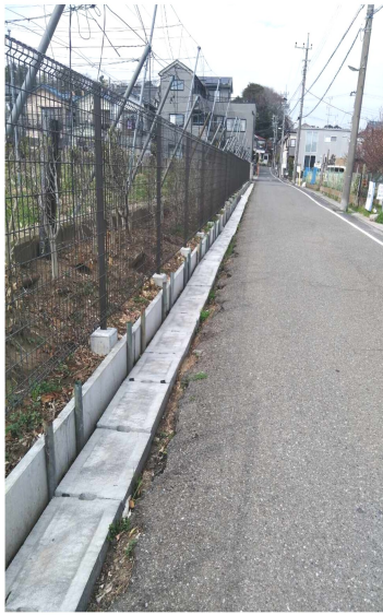
側溝の蓋掛けが実現（宮久保地域）
