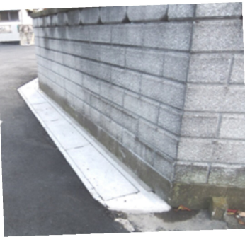
壊れた側溝が整備 （曾谷地域）
