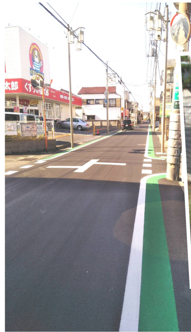
道路舗装が実現。宮久保商店街通り
