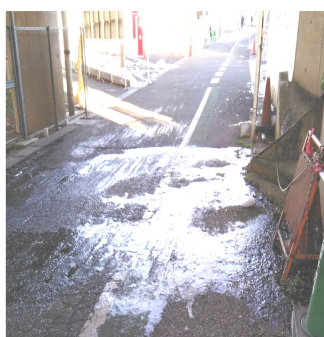
常に道路がぬかるみ、冬 凍結（武蔵野線高架下）
