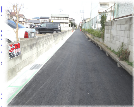
市政アンケートで寄せられた側溝と道路舗装が実現（曾谷小：西側道路）
