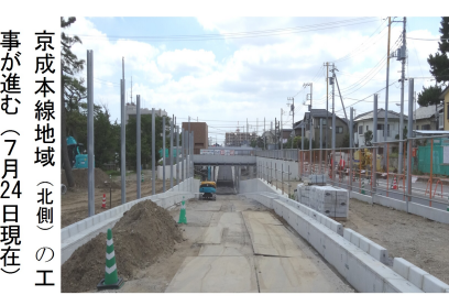
京成本線地域（北側）の工事が進む（7月24日現在）
