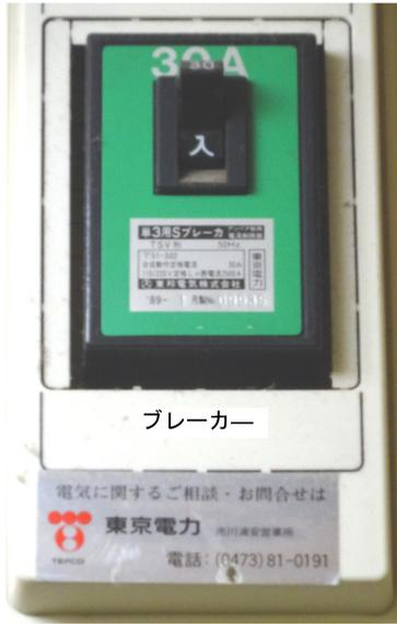
感震ブレーカーは、内蔵されたセンサーによって揺れを感知し、ブレーカーを落として電力供給を遮断し、電力による出火を防ぎます。震度5強相当で動作し、3分後に電力が遮断されます。今年7月から実施。既存の住宅（マンションは専有部）で設置で
