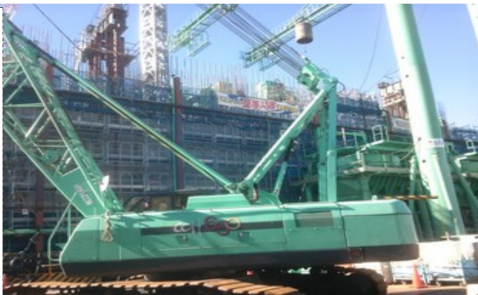
工事中的の大和田ポンプ場
